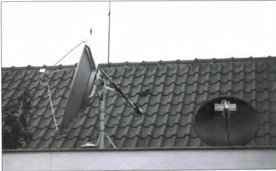
Een 2-meter schotel met polar mount en actuator. Daarnaast een 90-cm prime focus.
